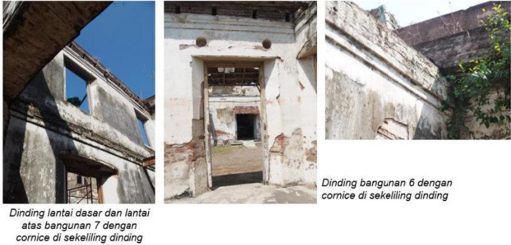
Gambar F.37 dinding lantai dasar dengan cornice
