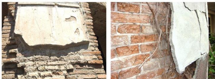
Gambar B.1.12. Plesteran (kiri) dan acian dinding tembok kuno (kanan)
