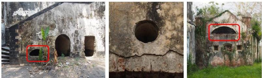
Gambar F.19 Ventilasi yang ada pada bastion benteng
