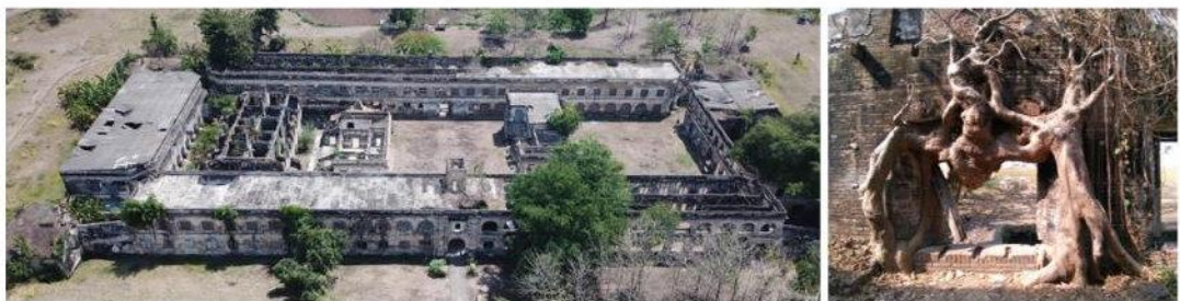
Foto udara memperlihatkan atap bangunan sebagian besar sudah tidak ada lagi.
