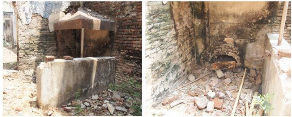
Tungku yang terdapat pada bangunan 3
