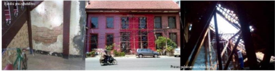
Gambar C.1.6 rehabilitasi Toko Merah, Jakarta Barat
