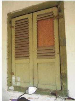
Jendela kayu berdaun ganda, dengan daun jendela panel kayu dan krepyak
