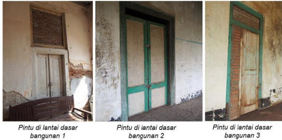
Gambar F.33 Pintu pada ruang dalam
