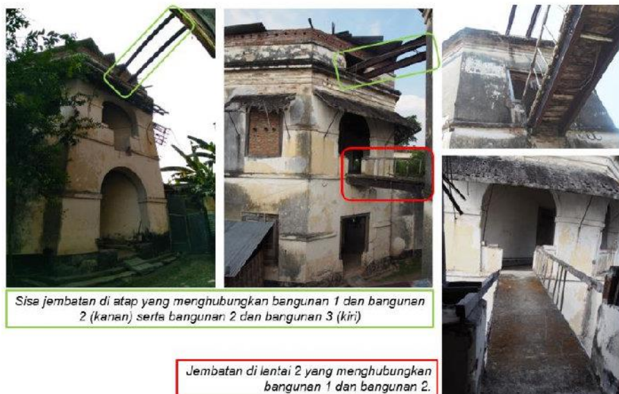
Gambar F.24 Jembatan pada benteng
