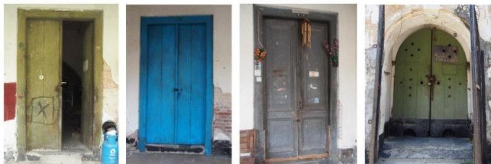
Gambar F.17 jenis pintu yang masih tersisa pada benteng
