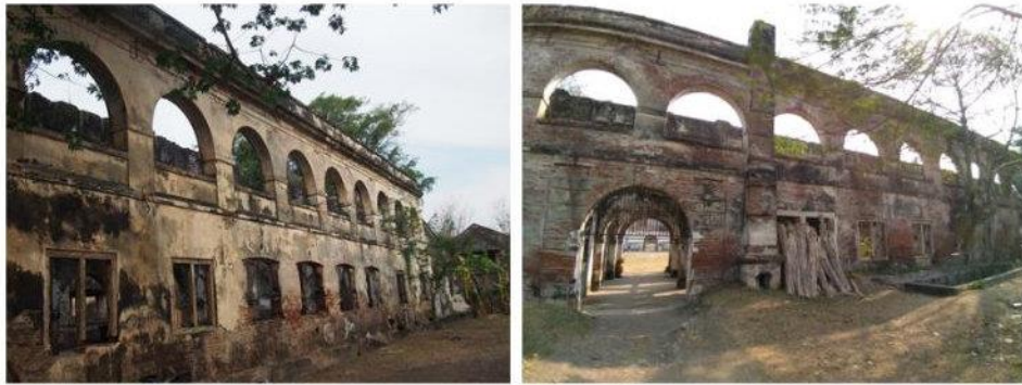
Gambar F.14 Dinding bangunan yang merupakan dinding struktur
