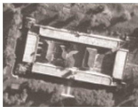
Bangunan I, II, III dan IV memiliki atap datar terbuat dari bata, sementara atap pada bangunan turutan merupakan atap jurai dengan penutup genteng
