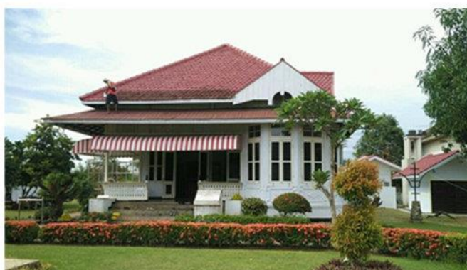
Gambar A.4.9 Rumah pengasingan Bung Karno di Bengkulu
