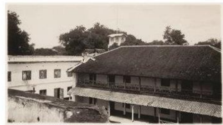
Atap pada bangunan turutan V
