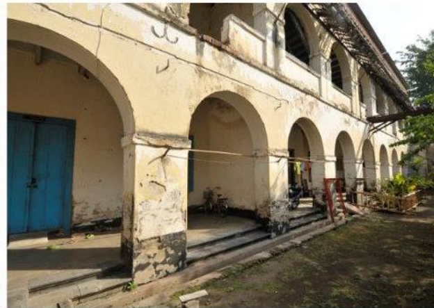
Arch pada lantai dasar dan lantai atas yang menghadap ke halaman dalam, melindungi teras
