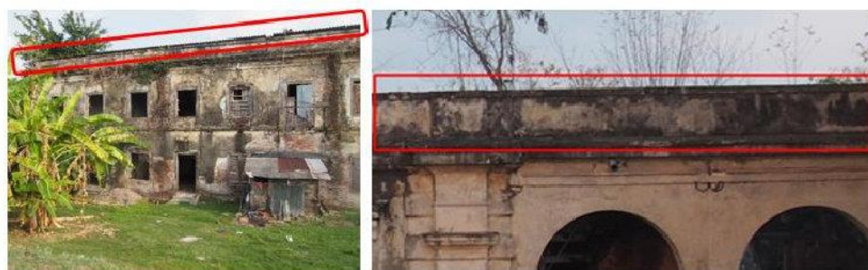
Gambar F.27 parapet pada pinggi atap bangunan 1,2, 3 dan 4
