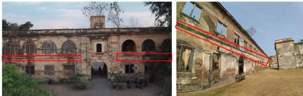
Cornice yang terdapat pada dinding eksterior bangunan 1, 2, 3 dan 4
