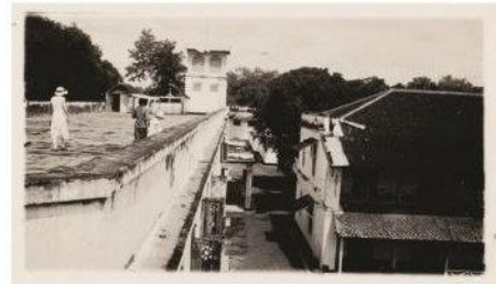
Atap pada bangunan I
