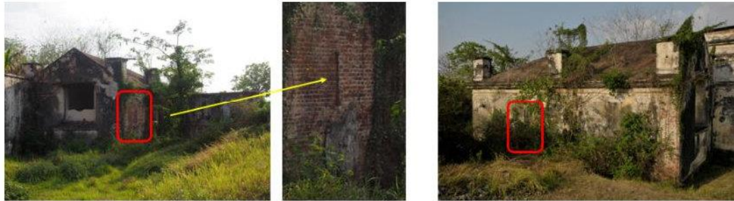
Gambar F.16 Lubang bidik yang terdapat pada dinding luar bangunan 8,9,10 dan 11
