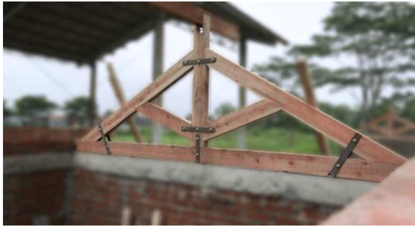
Gambar 28. Kuda-kuda Kayu Dengan Pengikat Plat Baja
