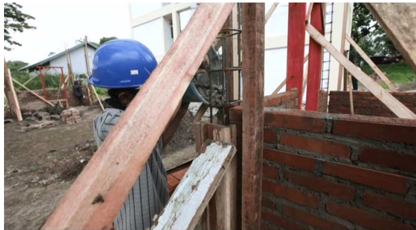
Gambar 56. Proses Pengecoran Kolom
