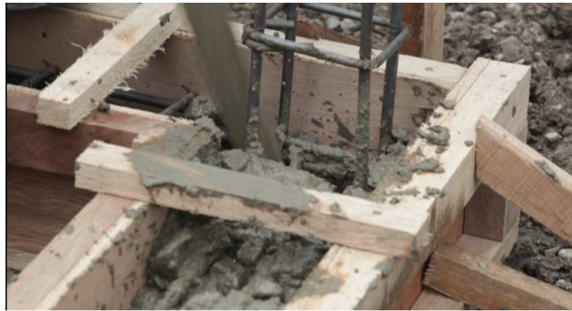
Gambar 58. Pengecoran Balok Pengikat/ Sloof
