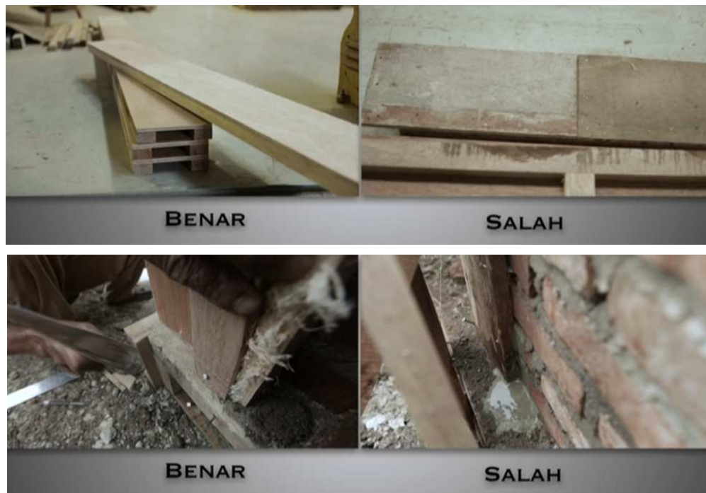
Gambar 54. Kualitas Cetakan/ Bekisting
