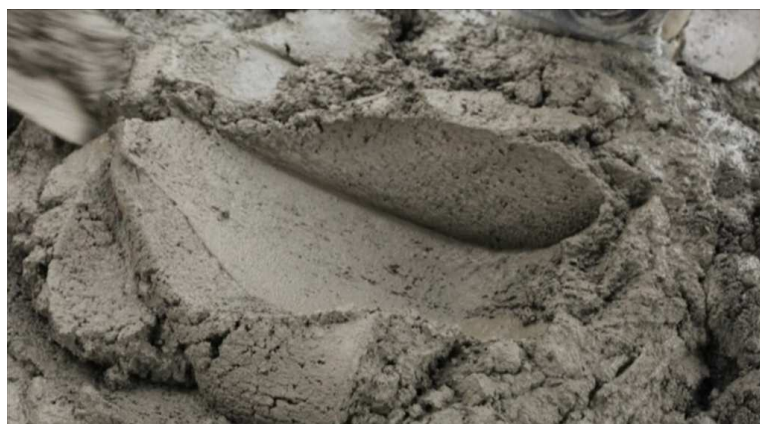
Gambar 9. Hasil Pencampuran Mortar Yang Baik
