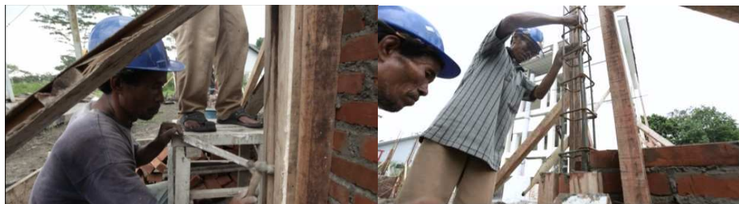
Gambar 57. Pemasangan Beton Dengan Memukul-mukul Cetakan/ Bekisting dan Campuran Beton Dirojok Menggunakan Besi atau Bambu
