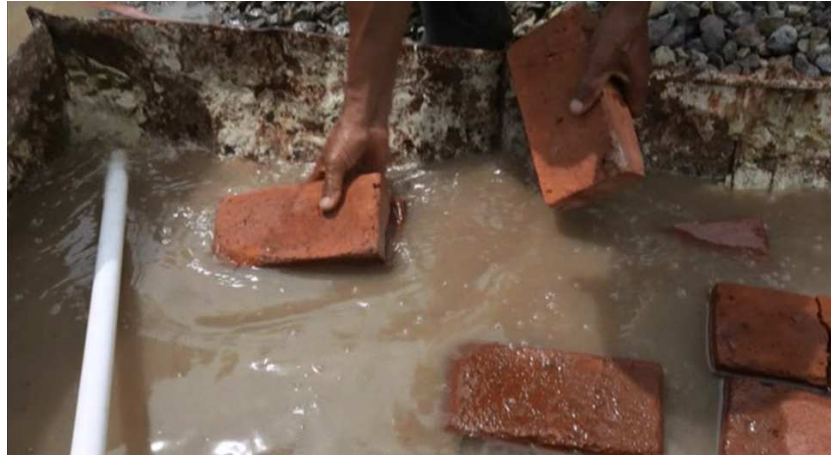
Gambar 15. Perendaman Batu Bata Sebelum Dipasang
