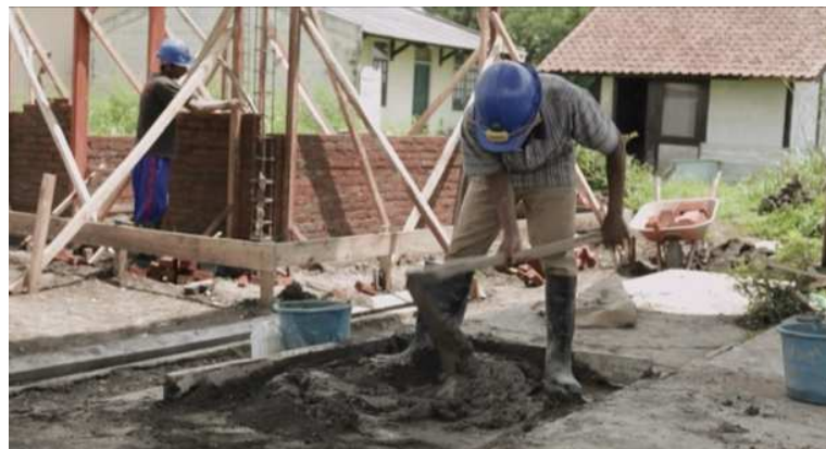
Gambar 8. Proses Pencampuran Mortar
