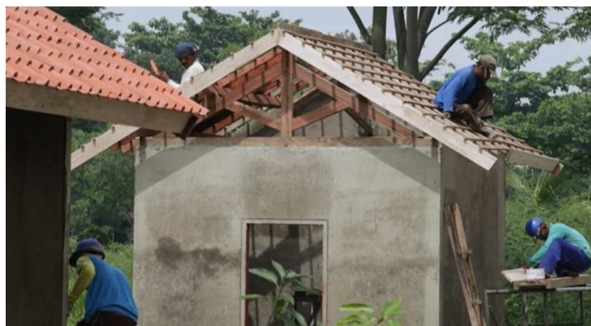
Gambar 27. Kuda-kuda Kayu Pada Atap Rumah Tinggal
