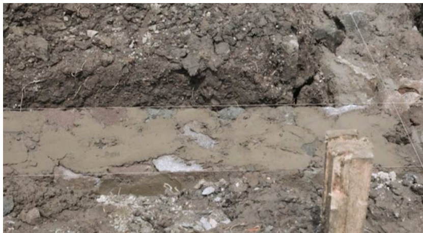
Gambar 11. Pondasi Dari Batu Kali/Gunung
