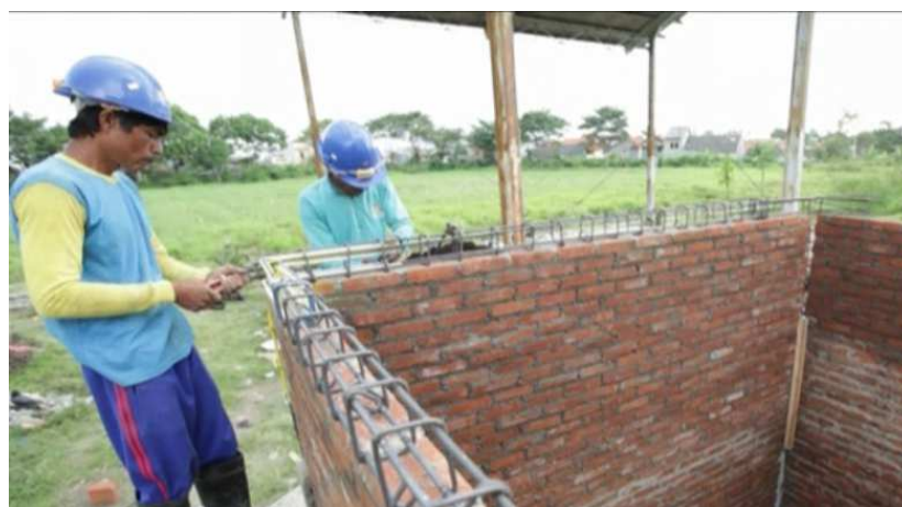
Gambar 58. Pengecoran Balok Pengikat/ Sloof
