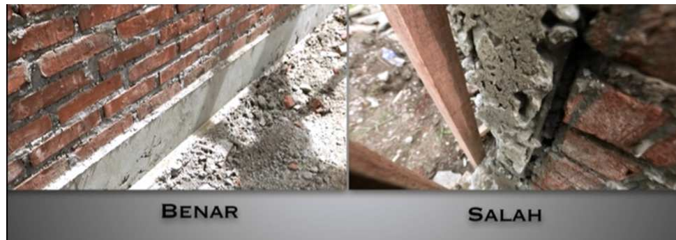
Gambar 58. Hasil Pengecoran
