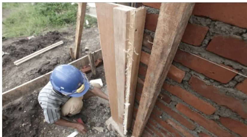
Gambar 55. Pemasangan Cetakan/ Bekisting Untuk Kolom
