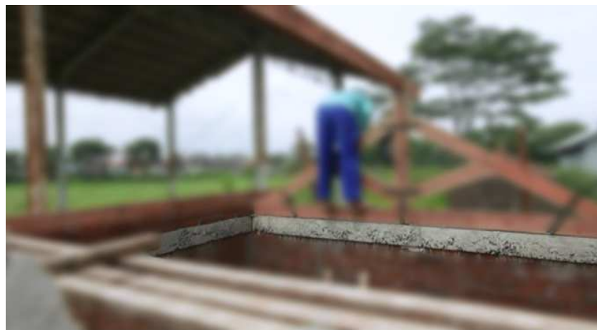
Gambar 22. Balok Keliling/ Ring
