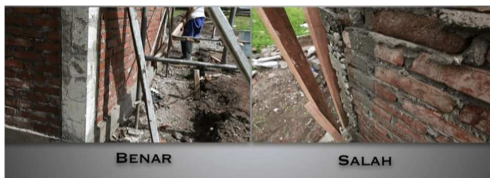
Gambar 57. Pemasangan Beton Dengan Memukul-mukul Cetakan/ Bekisting dan Campuran Beton Dirojok Menggunakan Besi atau Bambu
