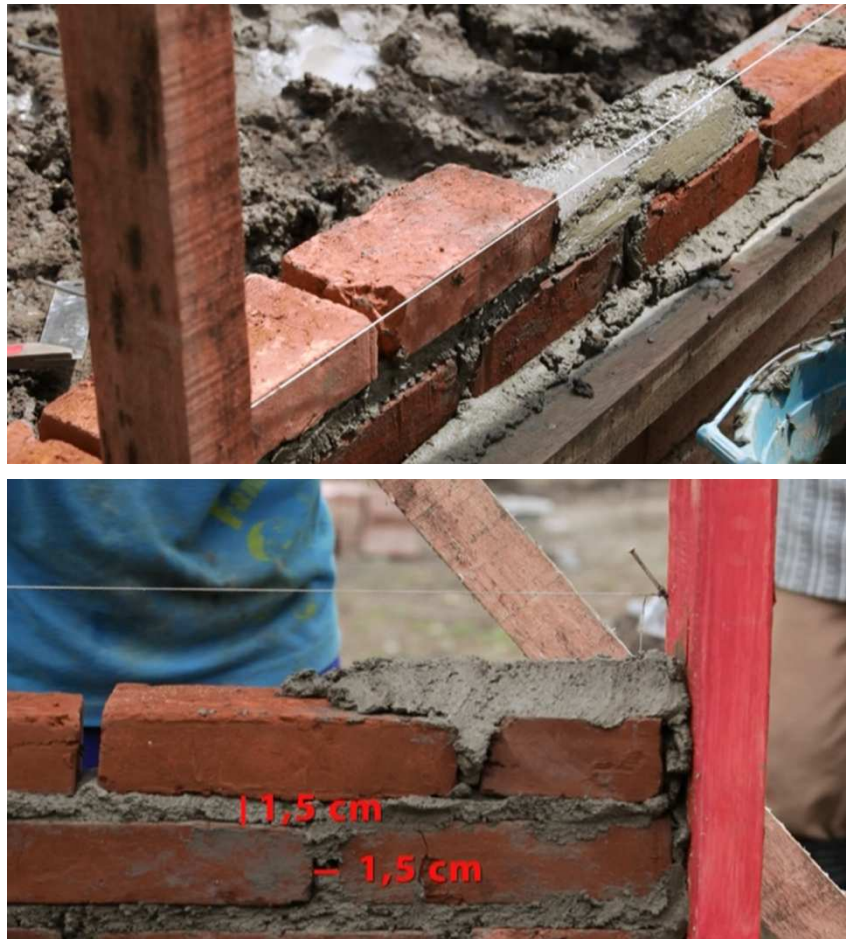
Gambar 41. Proses Pemasangan Batu Bata Untuk Dinding
