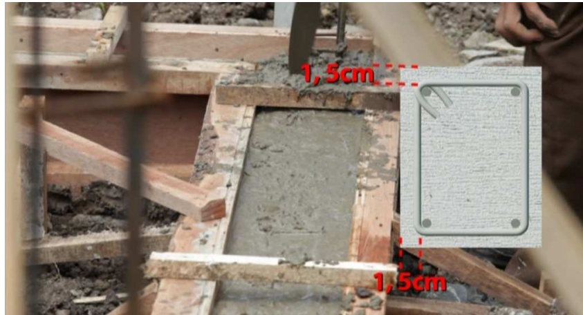
Gambar 19. Balok Pengikat/ Sloof
