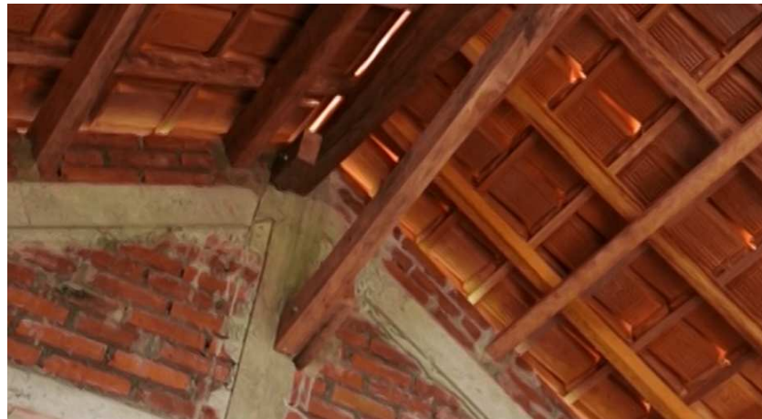
Gambar 37. Pertemuan Antara Ikatan dengan Gunung-Gunung/ Ampig
