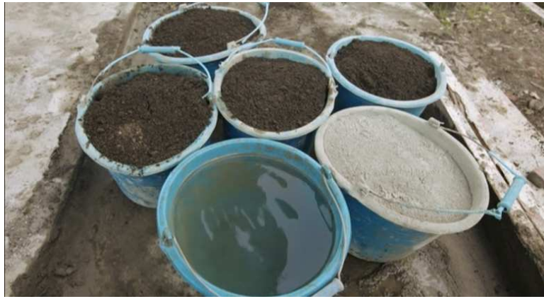
Gambar 7. Bahan Campuran Mortar
