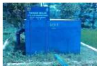
Gambar 3.14 Bak Pelepas Tekan (BPT)
