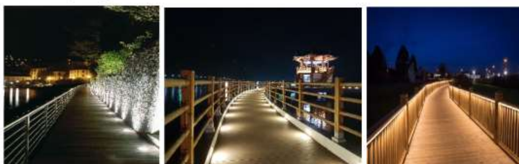
Gambar. Contoh Ilustrasi Panduan Lampu atau Penerangan Boardwalk up light lighting (kiri), recessed lighting (tengah) dan strip lighting (kanan).
