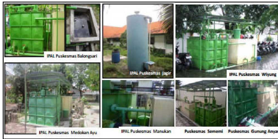
Gambar 2.7. Contoh Pembangunan IPAL Puskesmas
