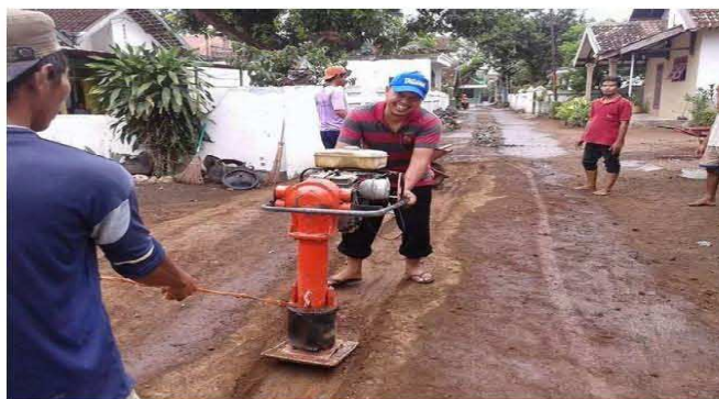
Gambar 12. Contoh Pemasangan Galian Pipa
