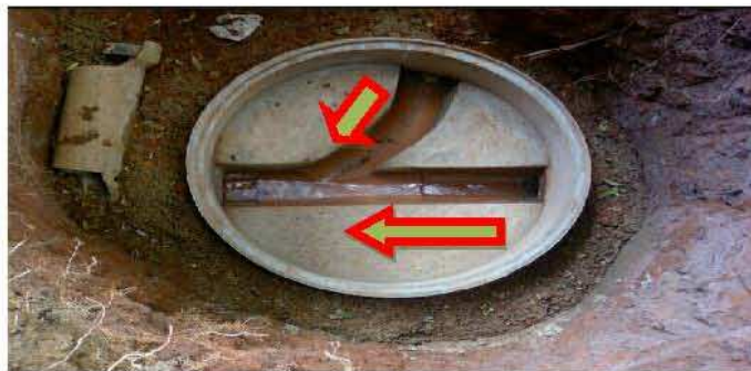
Gambar 7. Contoh Potongan Bak Kontrol (Precast)
