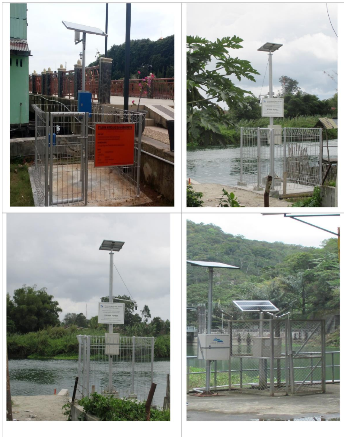
Gambar 6. Contoh Bangunan Pelindung Tidak Permanen
