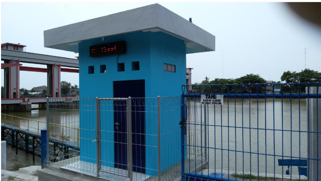
Gambar 4. Contoh Bangunan Pelindung Permanen
