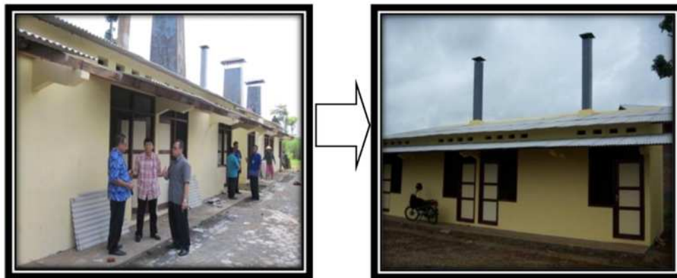
Gambar 2. Contoh Rehabilitasi Bangsal Pengolahan Ikan (Fungsi Cerobong Asap Diperbesar Sesuai Fungsi)
