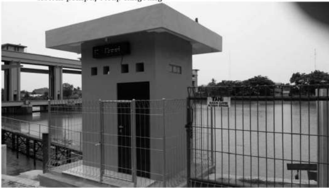
Gambar 4. Contoh Bangunan Pelindung Permanen
