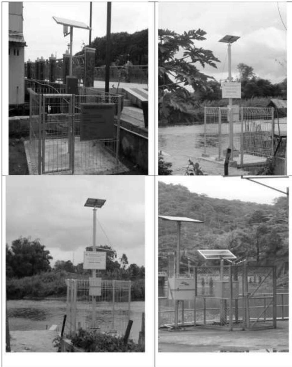
Gambar 6. Contoh Bangunan Pelindung Tidak Permanen
