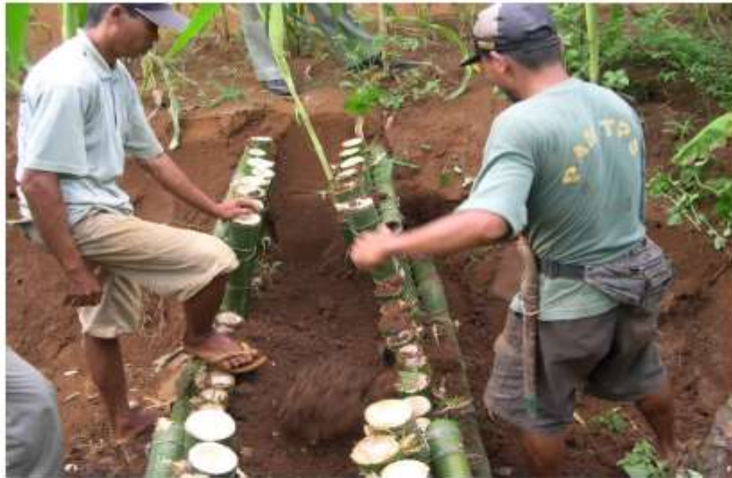
Gambar 4.43. Proses pembuatan Bio Gully Plug
